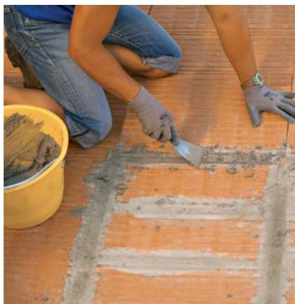
**3.** Si stende una membrana per evitare il contatto tra cemento e terracotta. Si procede realizzando la soletta con rete elettrosaldata. – *A membrane is laid so that there is no contact between concrete and terracotta. Then the slab of concrete can be poured with an arc-welded mesh.*
