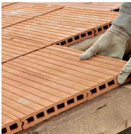
**2.** Dopo la posa di tutte le tavelle, nella superficie non a vista si passa un rasante. – *After all the tiles have been laid, a grout is spread in the part that is not visible.*
