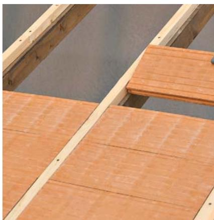
**2.** Dopo avere rasato le fughe, si disporrà lo strato isolante, base di partenza per gli strati successivi. – *After spreading the insulator over the tiles, we place the isolating layer, the base for all roofs.*
