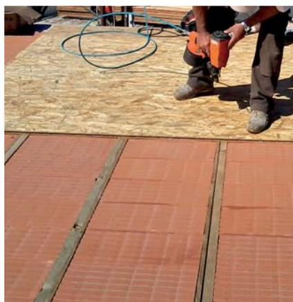
**3.** Quindi segue il montaggio di tavole dello spessore di progetto posizionate a 45 gradi rispetto alla parete. – *Then we lay down strips of wood with projected thickness and we place this layer posed at 45° toward the wall.*
